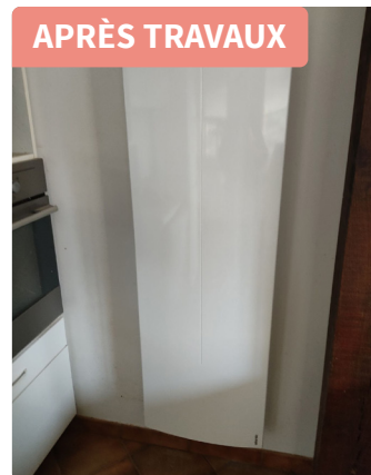
Le radiateur a été changé, la puissance n'était pas adaptée à la dimension de la pièce.
