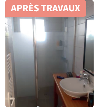
Réfection de la salle de bain.
